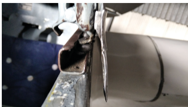
Fot. 2 Patologiczny przykład zużycia prowadnicy i rolek tylnej owiewki SZD-9bis (mat. autora)
